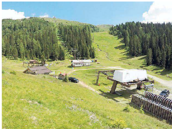
Gli impianti di Busa Ferrari, al centro del dibattito sul passo Rolle
